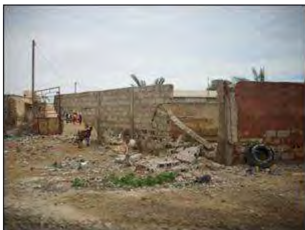
Photo 8: Grandes brèches sur la clôture du magasin
