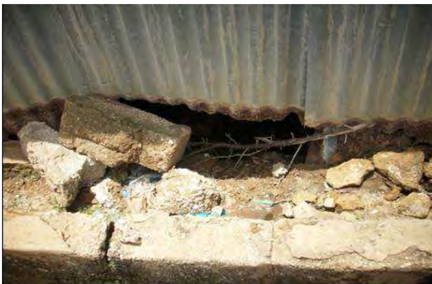
Photo 15: La base du magasin (en tôle de zinc) rongée par la rouille
